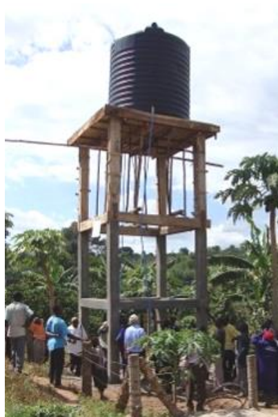
Von links nach rechts: Die Photovoltaikanlage im umzäunten Brunnengelände, der hochgestellte 10.000-Liter-Tagestank und eine der drei Wasserentnahmestationen im Ort.
