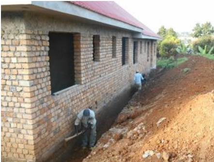
Bild oben: Außenarbeiten am unverputzten Haus, um Nässeschäden in der Regenzeit vorzubeugen, Stand: Anfang September 2018
