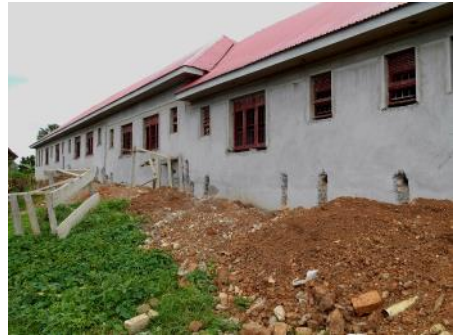
Bild oben: Gebäudeansicht von der unteren Seite. Ende September war der Außenputz großteils fertig und die Fensterrahmen eingemauert.
