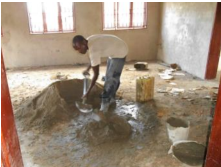
Bild unten: einer der Arbeiter beim Mörtel mischen für den Innenputz ohne Mischmaschine.
