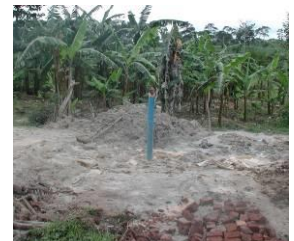
Fehlgeschlagene Brunnenbohrung
